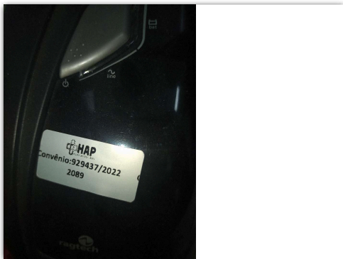
Nobreak - Patrimônio: 2089- Sala de laudo.
