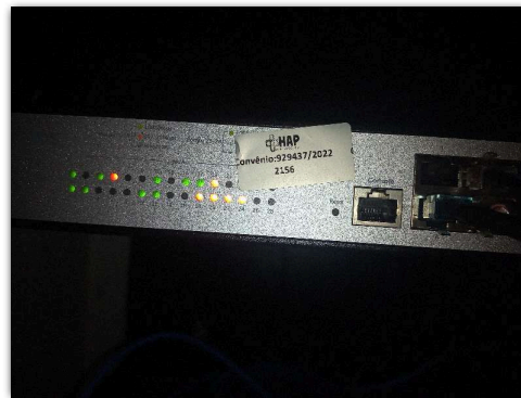
Switch - Patrimônio: 2156 - Recepção (CDI)
